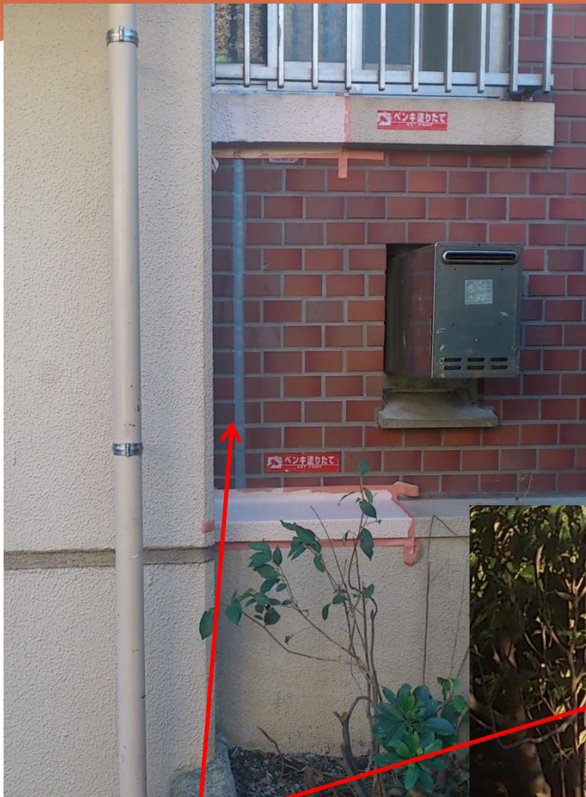
スリット工事部分
