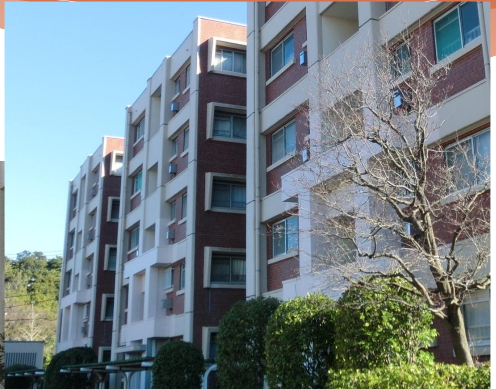
耐震改修後の外観
