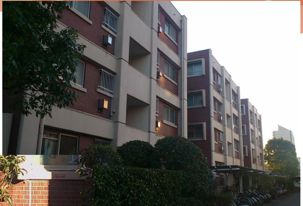
耐震改修後の外観
