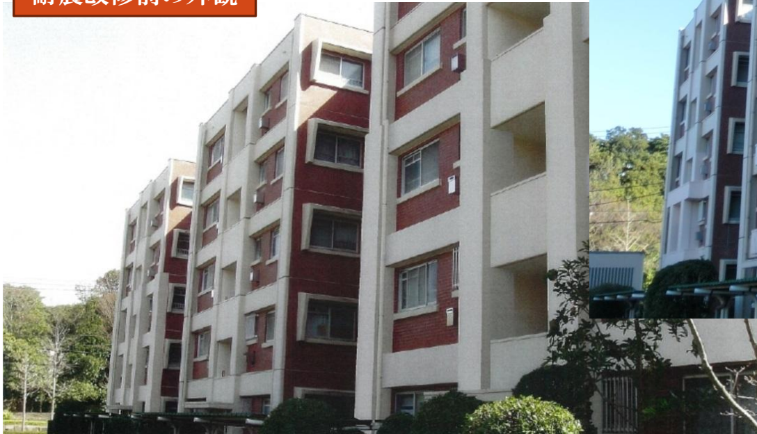
耐震改修前の外観
