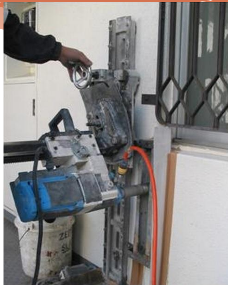
部分スリットを施工している様子
