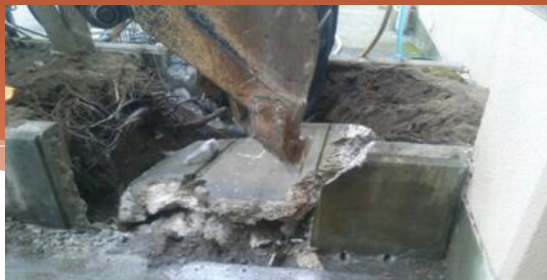
階段入口脇植栽壁の撤去
