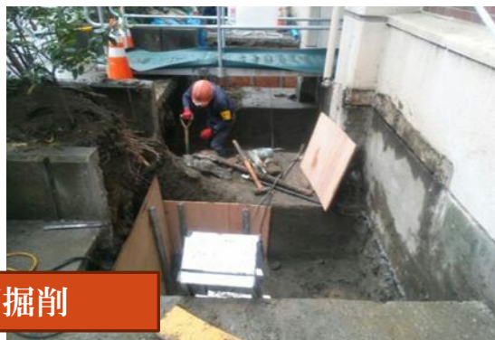
階段入口脇植栽壁の撤去
