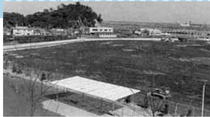
昭和48年 埋め立て造成中の富岡沖 (富岡シーサイドコーポ付近から富岡八幡宮方面を望む)
