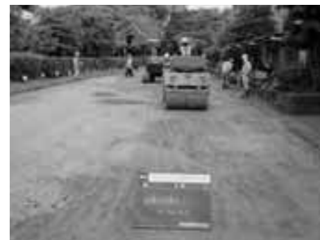
平成18年 敷地内の舗装改修工事
