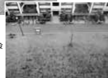
昭和61年 駐車場建設 工事開始 (83台増設)
