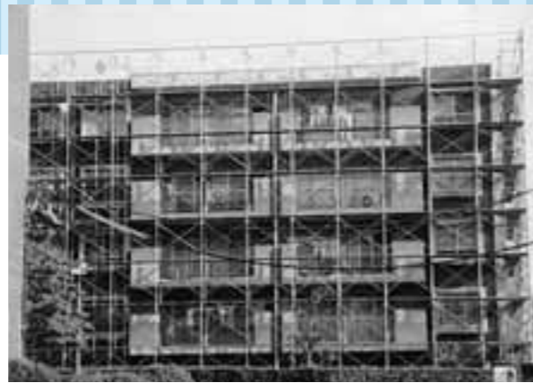
平成5年 外壁等改修・屋上防水工事に伴い足場が設置された
