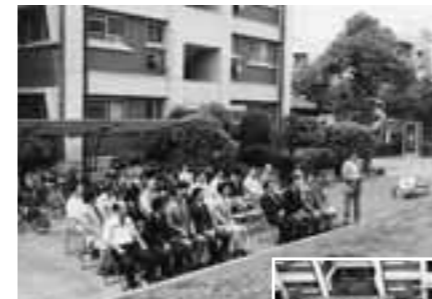
昭和61年 地鎮祭 (駐車場建設)
